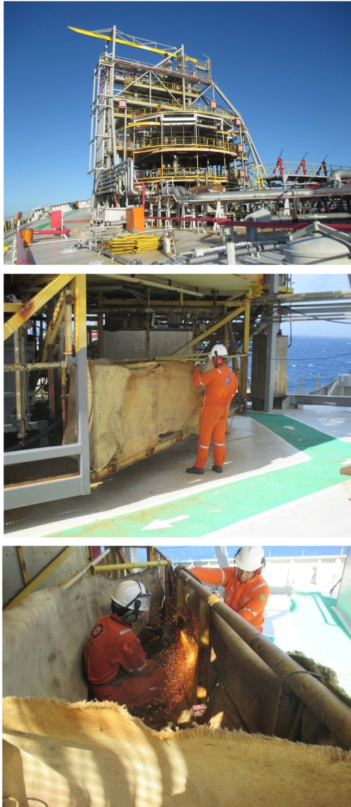
Figura 4.11 – Cenário de trabalho a quente em área classificada na Plataforma (Turret) Fonte: Fotografado pelo autor, 2015
